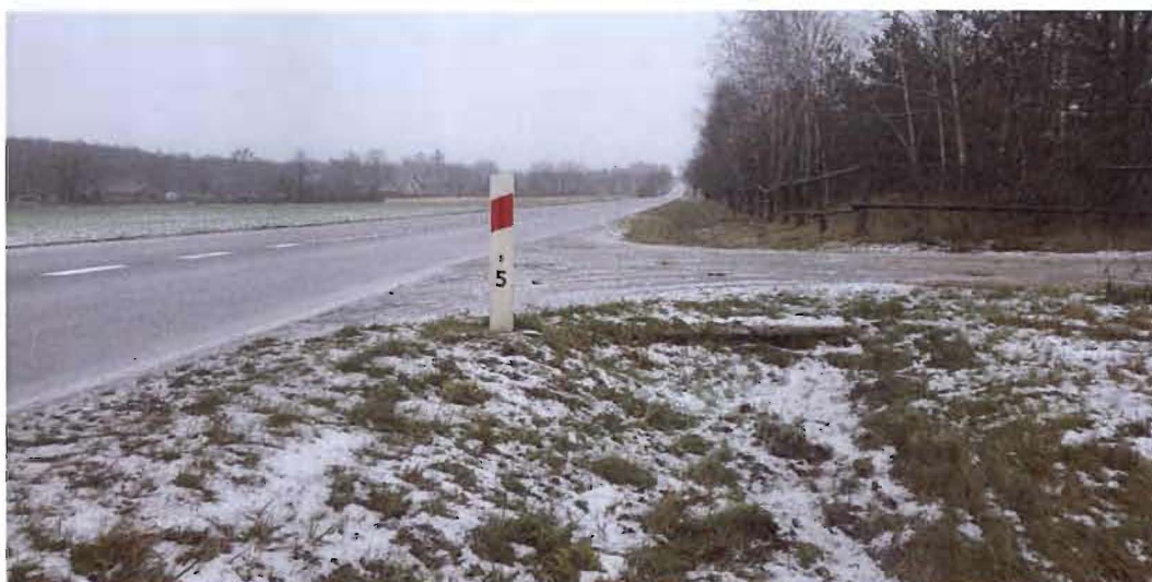
Rys.1. Istniejący przepust betonowy Ø500mm
